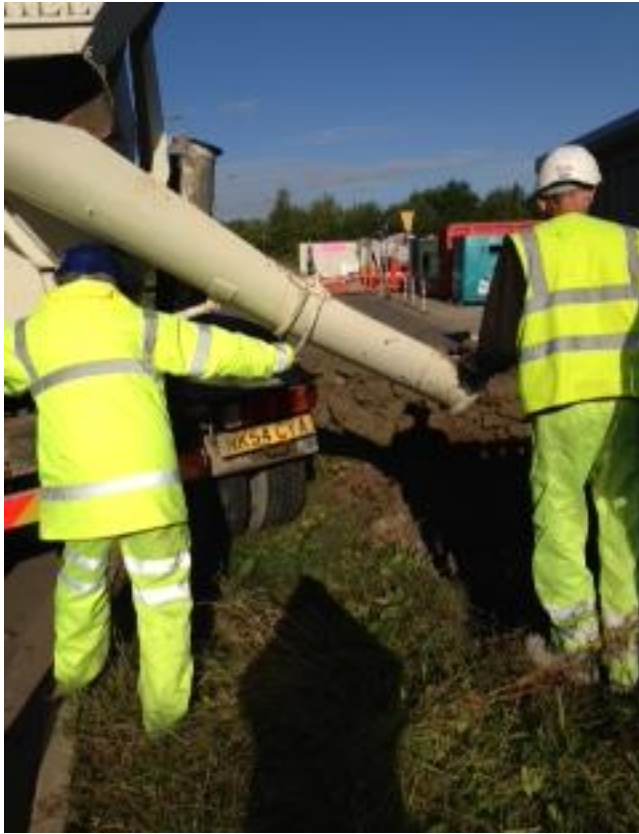
Figures 4.36 Process of Concrete Pour
